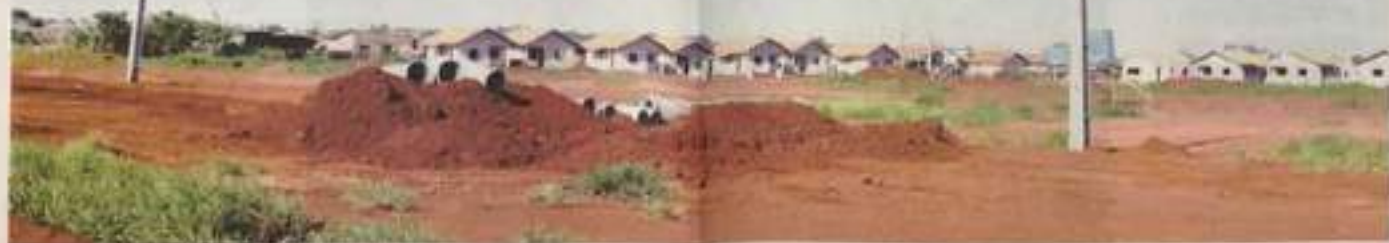
Conjunto habitacional com 42 unidades recebe obras de infraestrutura
